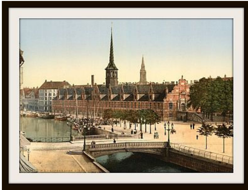
l'admirable édifice renaissance de la Bourse, også bygget under Chr. IV, spiret er fra 1695.
